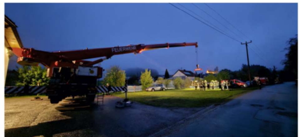
Vorstellung Kran Bad Leonfelden, 19.04.2024
