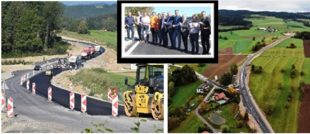
Ausbau B 38 - Baulos Zimmerhofer
